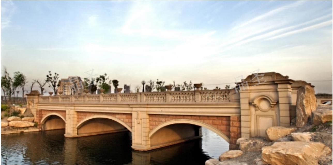
桥梁景观装饰晶铸石栏杆主要采用特种水泥加钢筋及石英砂等材料按一定的比例通过模型浇注形成的栏杆，后期在经过特殊的工艺处理成和石栏杆差不多的精造石护栏，晶铸石栏杆也可以和其他形式的护栏组合成不同形式的组合护栏。晶铸石栏杆有着造型美观、时尚、环保、抗老化、不易变形、造价低廉的性能优点，晶铸石栏杆可普遍用于市政、水利、公园、道路、桥梁护栏等护栏工程。随着城市建设的不断深入的发展与拓开，越来越多的园林景观开始使用并推广晶铸石护栏产品。使得晶铸石护栏产品越来越深入消费者与观众的喜爱与认可。
